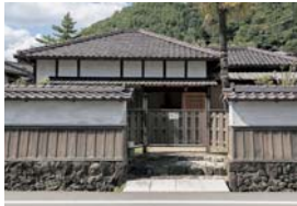
▲独自の宿舎を修復し、瓦の規格と技法が古く、生野瓦の景観を再現した。
